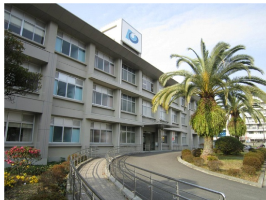
【朝倉キャンパス】 総合研究棟玄関付近
