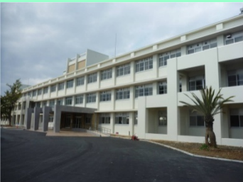
農学部 1 号館改修
