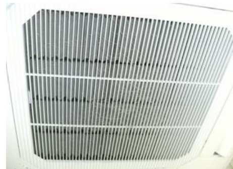
C棟 実験室
