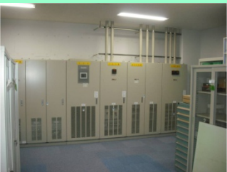
海洋コア無停電電源装置設置
