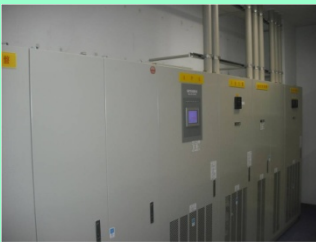
海洋コア無停電電源装置設置
