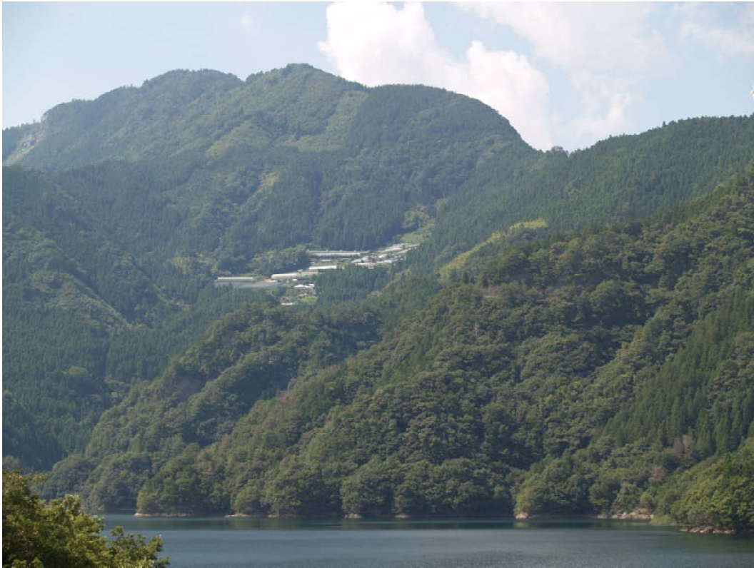
第2図 早明浦ダム北岸の急傾斜面に拓かれた農地
