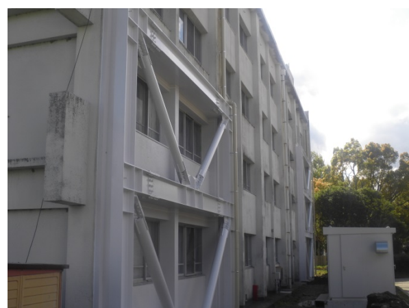
物部キャンパス学生寄宿舍（日章寮）耐震改修
