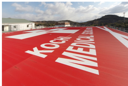
屋上に設置したヘリポート
