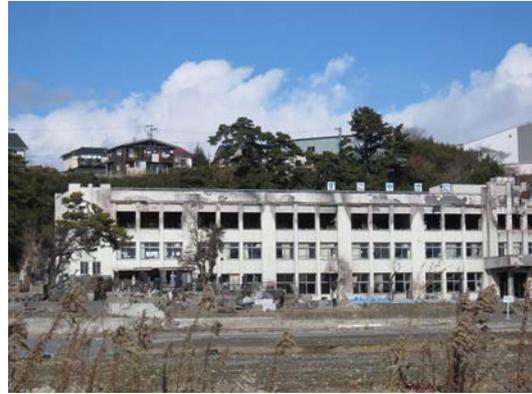
Fig. 4. 津波の直撃ならびに押し寄せた車両火災により壊滅的な被害を被った石巻市立門脇小学校. 校舎最上階まで被災. 海岸からの直線距離は約 750m. 津波が遡上した北上川河岸からは約 500m.
