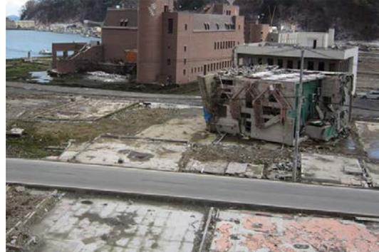
Fig. 5. 津波で横転した4階建てのビル(宮城県女川町). テレビでもたびたび目にする光景ながら, 現地では「重量物」の横転を改めて実感した.
